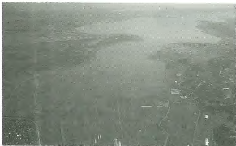
コンクリート護岸で縁取りされた高浜入り(昭和末期)
